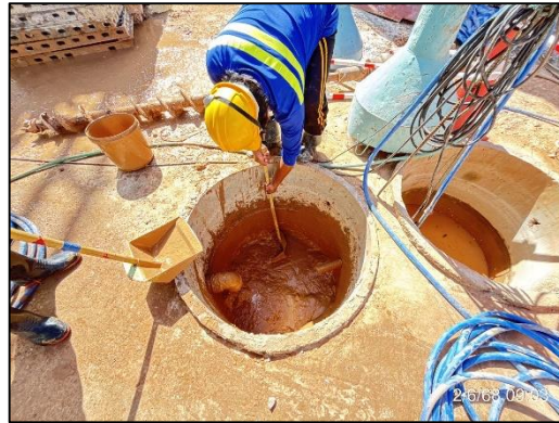
ภาพที่ 12 คนงานทำความสะอาดบ่อดักตะกอนดิน
